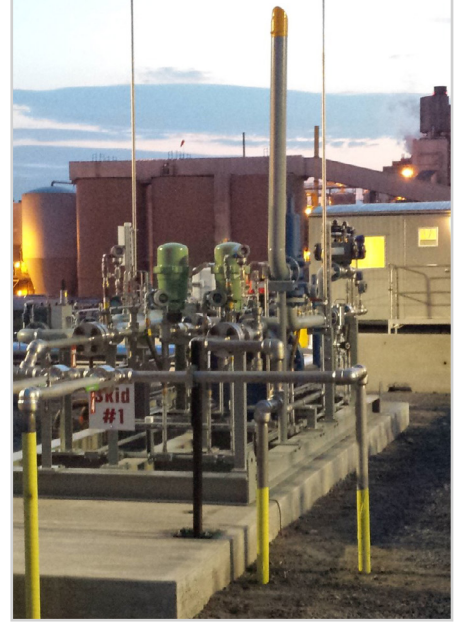
Resim Process Pipeline Services tarafından sağlanmıştır.
