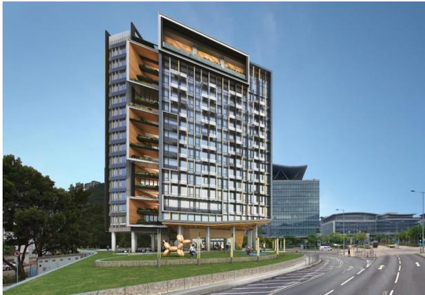
香港科技园创新斗室，项目占地面积 2948 平方米，总建筑面积 15300 平方米，这是一栋高 59.2 米，总共有 17 层的公寓建筑，也是香港第一个法定审批的模块化建造项目。中集模块化建筑充分发挥 DfMA（制造和装配设计）技术优势，在设计时即提前考虑制造和安装的要求，以高质量的模型指导设计、制造和现场的安装。
