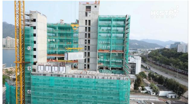
每间房屋都是完全设计的、独立的集成模块，在预制厂房中实现自动化和即时制造，预先完成的建筑墙板、内部装饰和机电工程也集成在模块中。这些模块全部在江门工厂生产，然后通过物流运输到香港。整栋建筑包括总计 418 个完整的单元，借助升降架在现场进行吊装，由工人完成最后的连接及高精度安装，误差不超过  $\pm 2\text{mm}$ 。全部模型安装用时 71 天，比计划提前 12 个月。通过模块化建造的方式，不仅缩短了工程实施周期，还有效地提高了施工团队的生产力，改善了项目质量和减少了环境污染，项目安全也实现全面改善，现场 0 事故发生。
