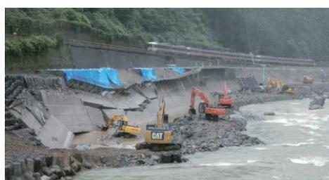
豪雨災害で被災した国道 41 号の復旧工事。約 2 週間後には JR 高山線が復旧した
