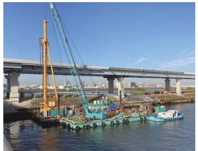
中川側の護岸に接する河床の地盤改良工事
