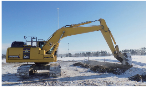
3Dマシンコントロール付きバックホーやブルドーザーを 駆使したICT活用工事の現場
