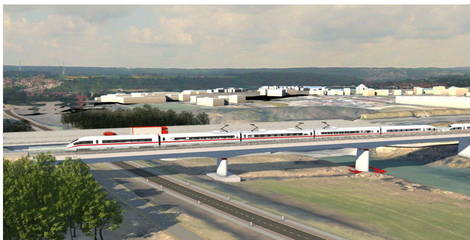
Neubaustrecke Stuttgart-Ulm Neckartalbrücke © Boll und Partner
