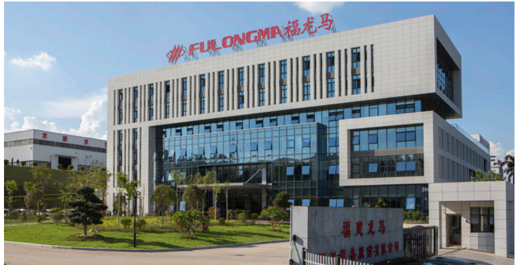
龙马环卫办公大楼
